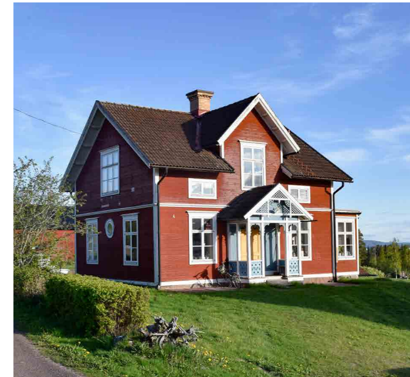
Många korsplanshus kan igenkännas på den strikt symmetriska fasadkompositionen, samt att skorstenen är belägen mitt över taknocken. Den vackra farstukvisten i snickarglädjestil är en annan detalj som är vanlig på korsplanshus. Garsås, Mora.
