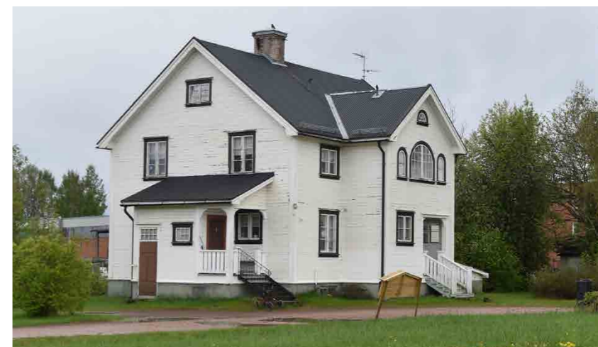
I trakterna kring Malung finns många byggnader uppförda under 1900-talet med liknande karaktäristiska framskjutande mittpartier. Hole, Malung.
