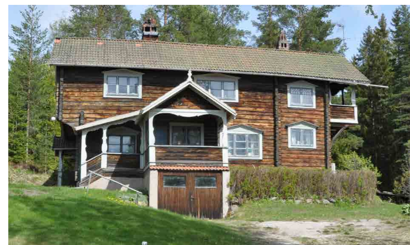
»Dalaromantisk« villa med karaktäristiska drag som kronskorstenar, utkragande gavelbalkong, farstukvistar med profilsågade detaljer och spetsiga fönsteröverstycken. Kärningberget, Leksand.
