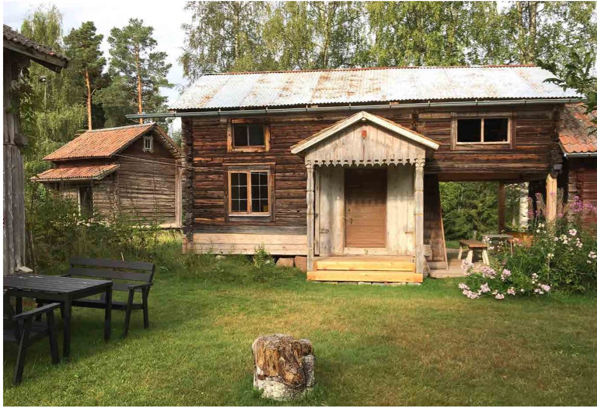
Gäststuga byggd helt och hållet av återbrukat material. Stommen är en äldre timmerbyggnad som räddats undan rivning genom att flyttas till platsen. Timmersmora, Ål. Foto: Elias Bernsveden.
