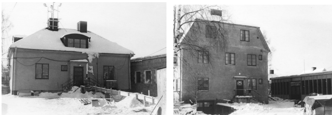
Numerera rivna byggnader på skolområdet, bilderna är tagna medan den "nya" skolan är under uppförande. Foton: Mora bygdearkiv
