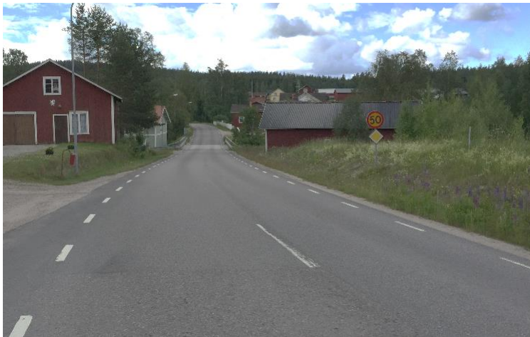
Figur 11. Väg 678 före åtgärd.
