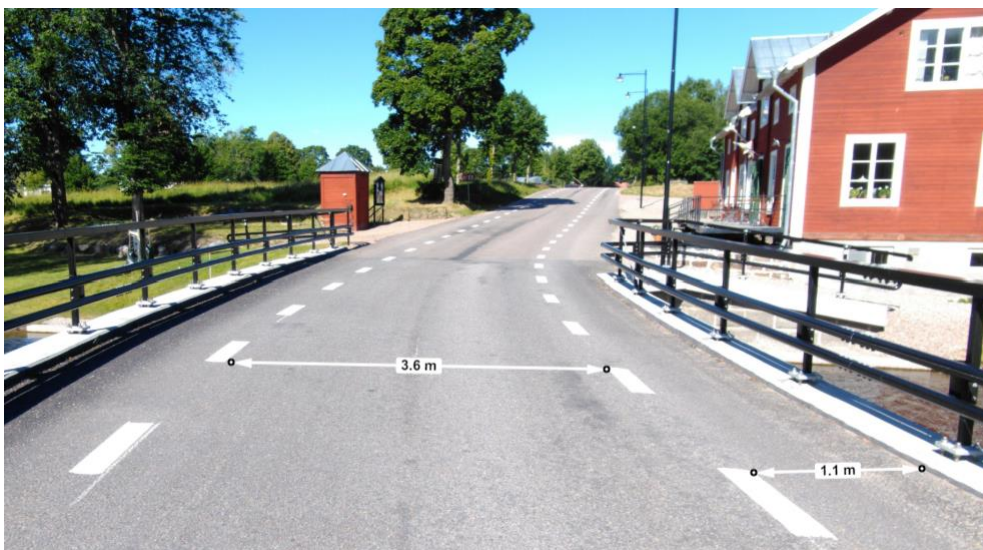
Figur 6. Ny bro, ca 3,5 m körbana och 1-1,1 m vägren
