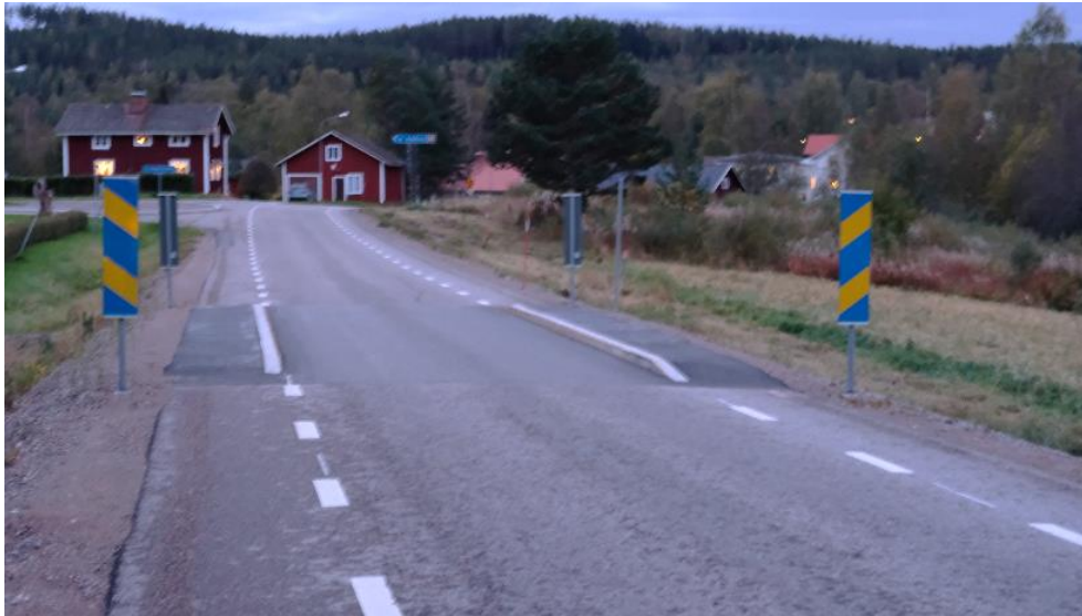
Figur 14. Dubbelsidig avsmalning.
