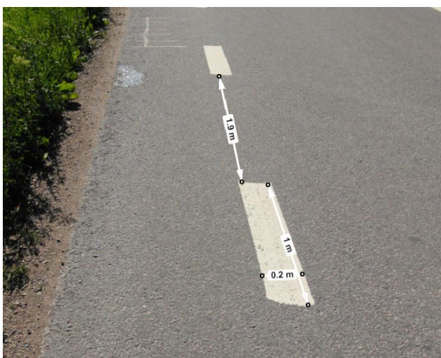
Figur 7. Vägmarkering väl utförd, slitage på vissa delar, bredd 0,2 m.
