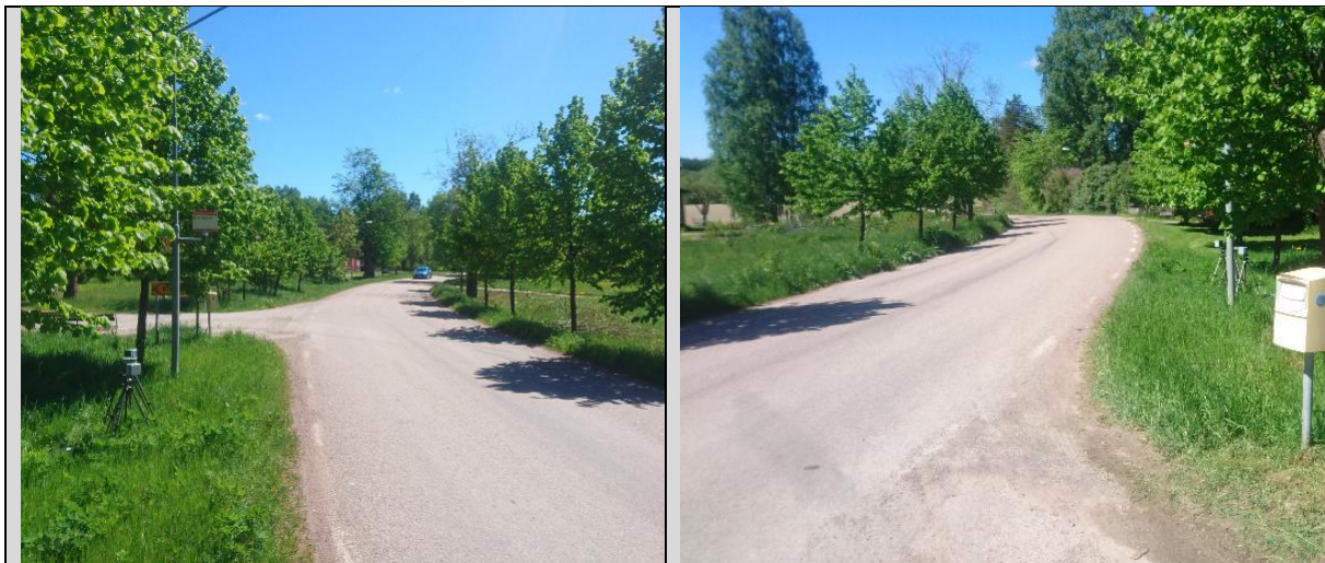
Figur 2. Bilder på sträckan före åtgärd.
